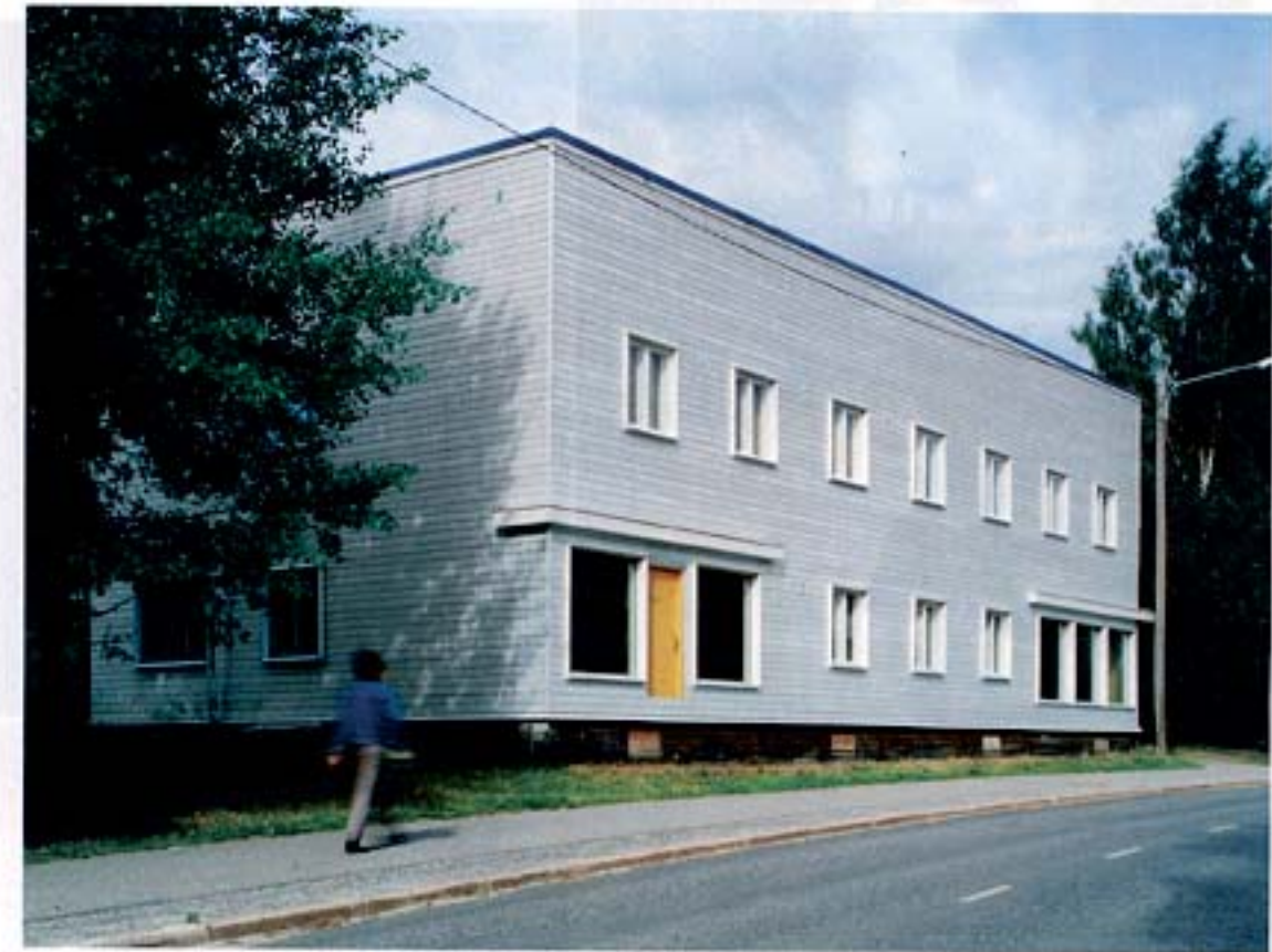
Vanha osuuskaupan talo edustaa 1930-luvun puufunkistyyliä aidoimmillaan. Tänä kesänä uudelleenverhoiltu funkiskuutio sai pintaansa valkoista petroliöljymaalia.
